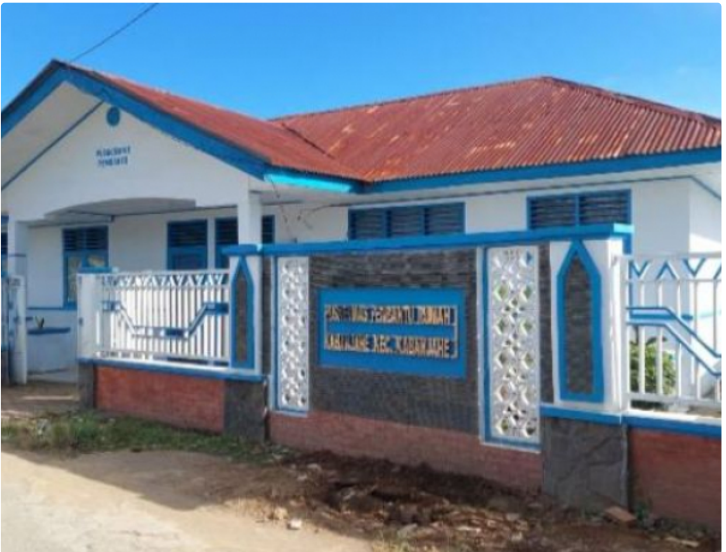
Puskesmas Pembantu di Desa Rumah Kabanjahe, Kecamatan Kabanjahe, Karo tak ada fasilitas listrik
